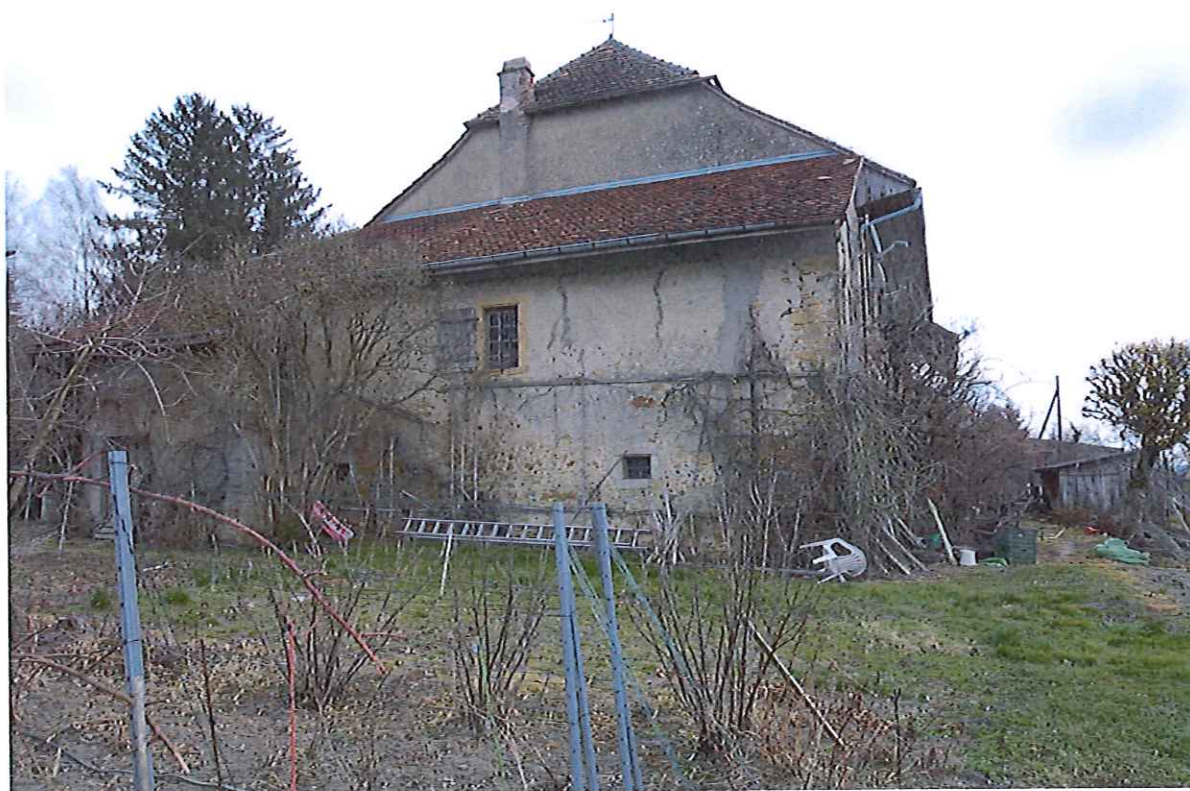
Vue de la façade Ouest
