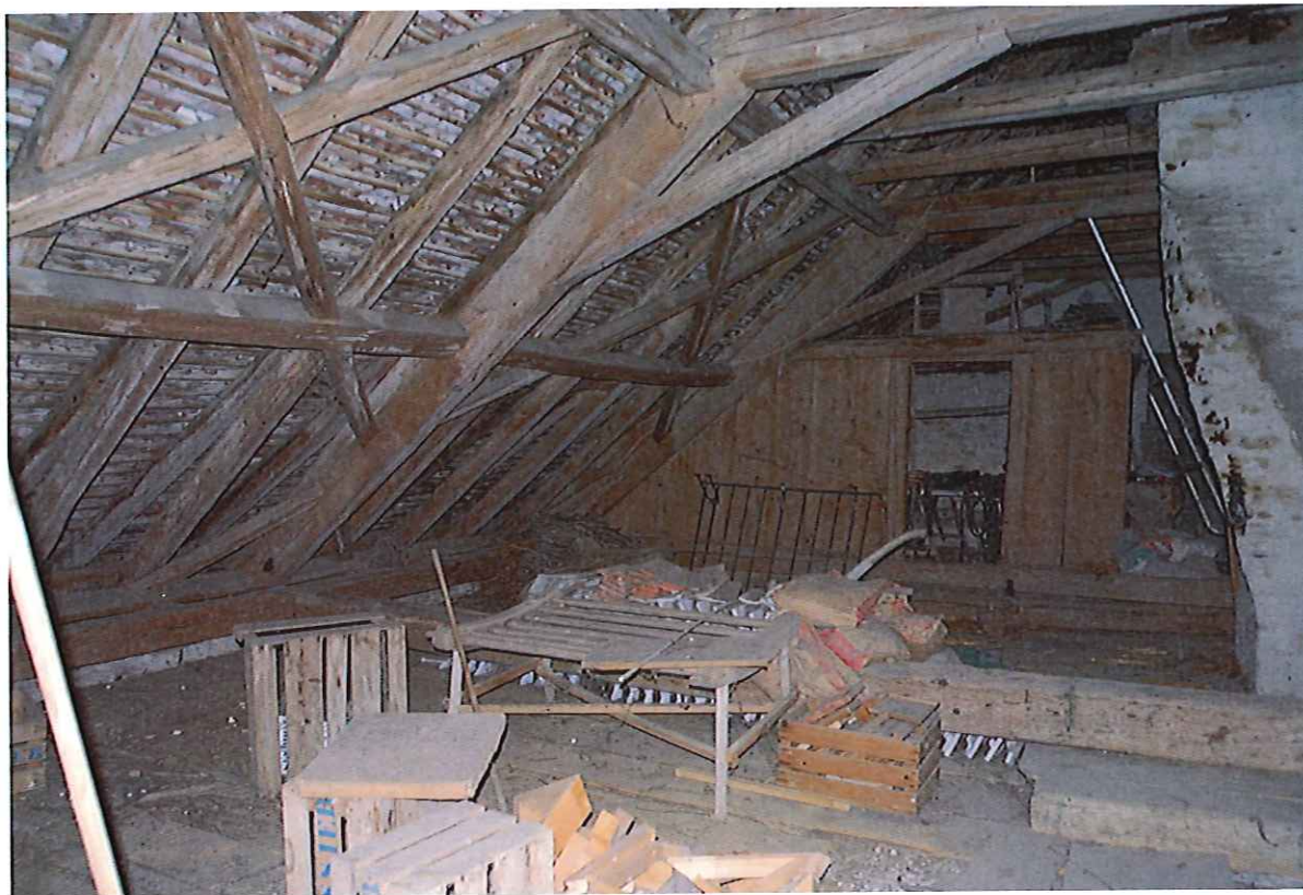
Galets dans les combles
