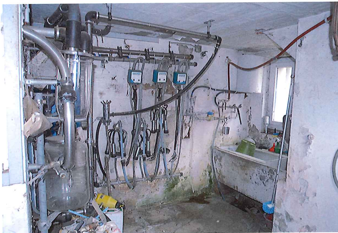
Ancienne salle de traite
