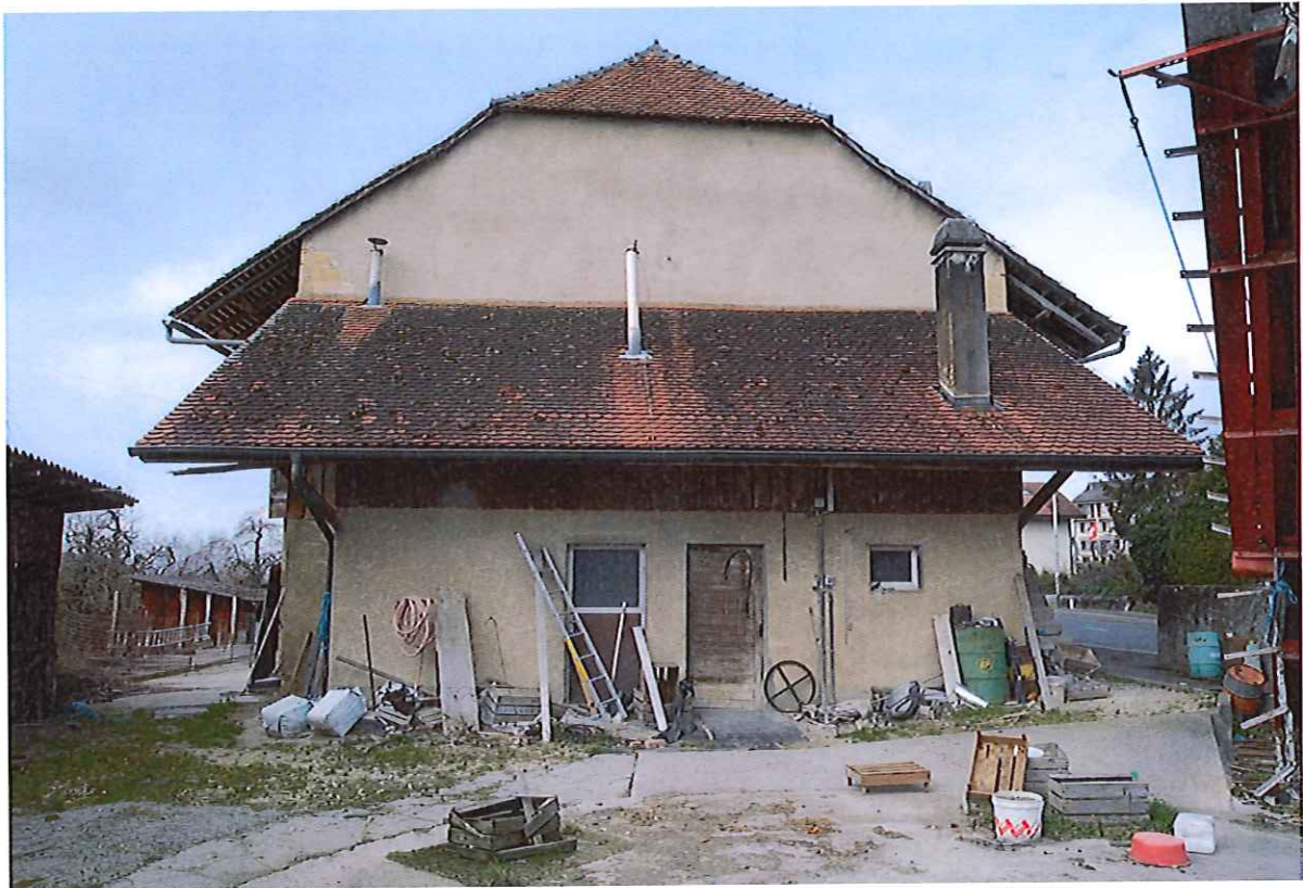
Vue de la façade Est
