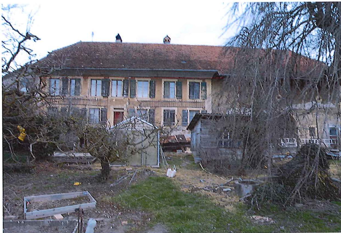
Vue de la façade Sud
