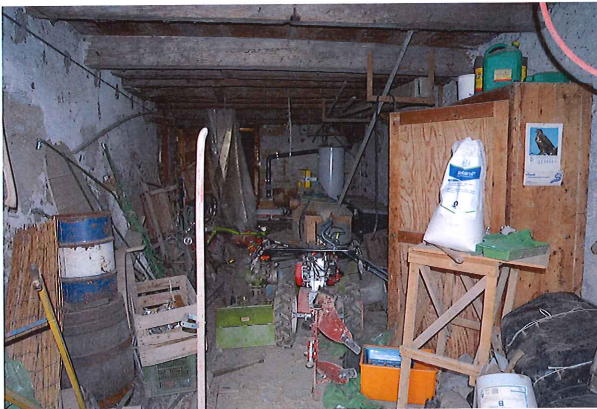
Dépôt au rez-de-chaussée
