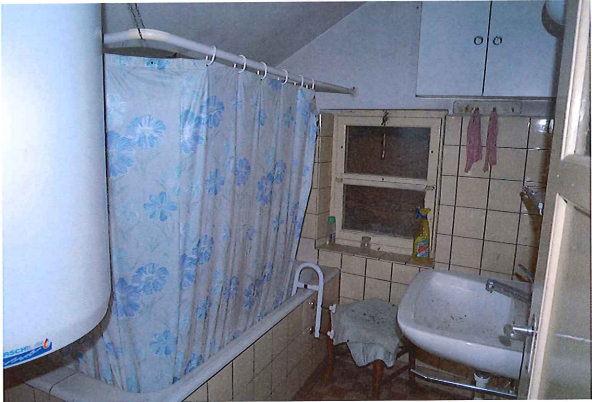
Ancienne salle de bain au rez-de-chaussée
