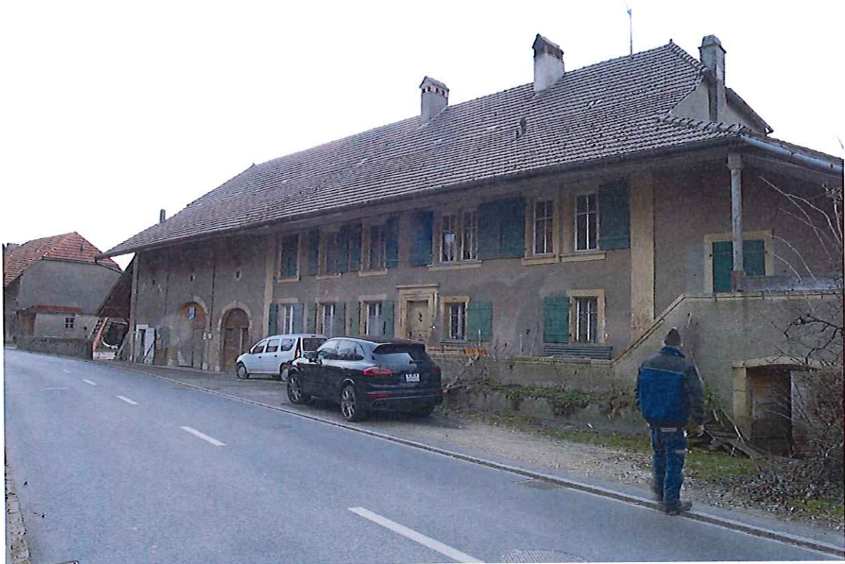
Vue de la façade Nord
