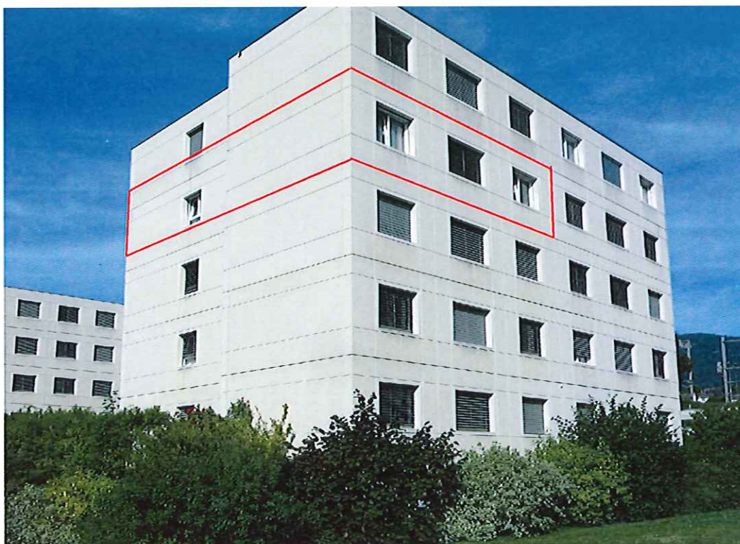
Façades Sud-Est et Nord Est
