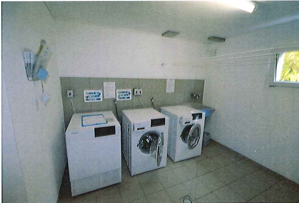
Buanderie commune au rez-de-chaussée
