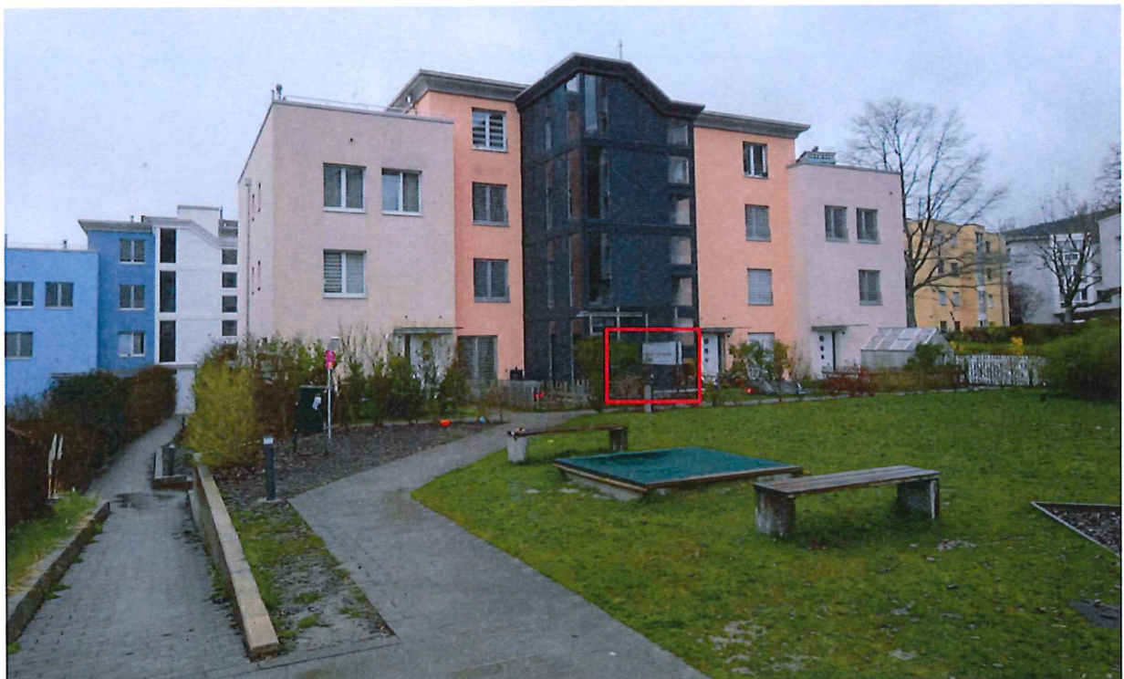
Vue de la façade Nord-Est
