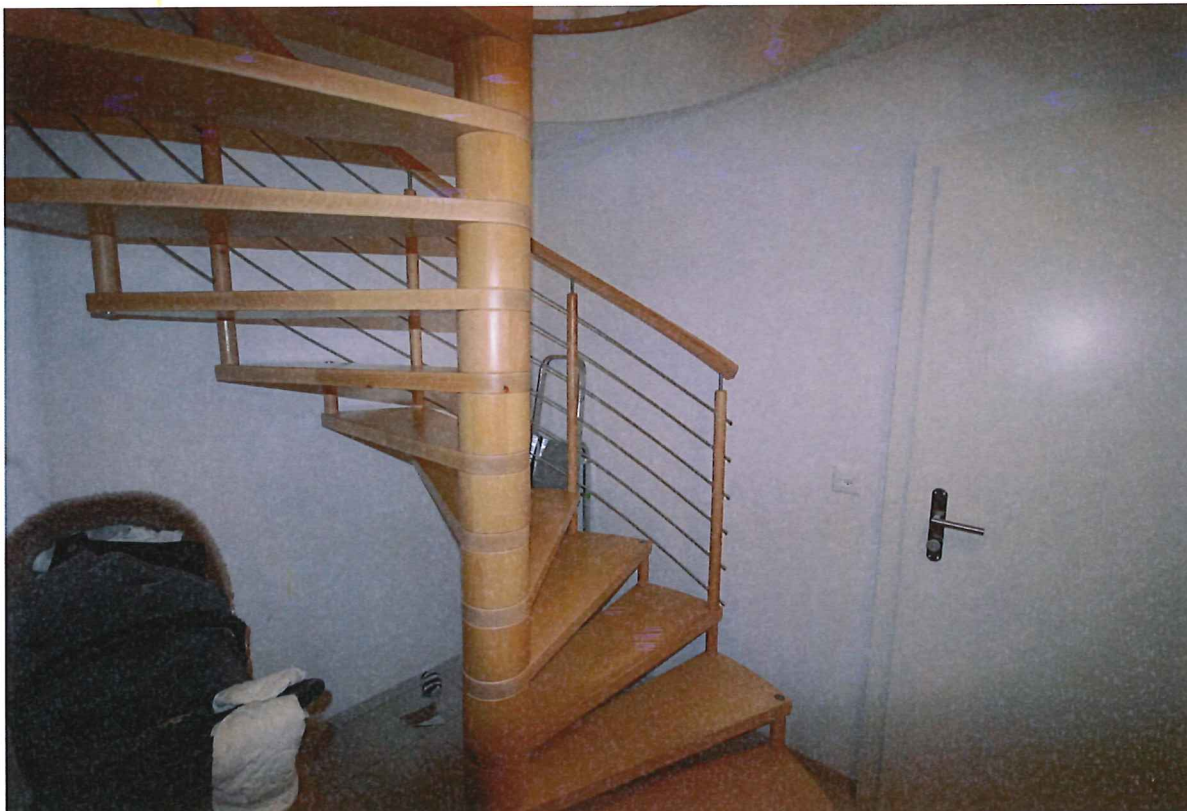
Escalier du sous-sol
