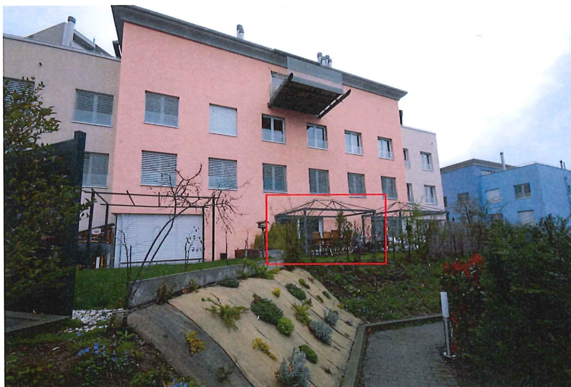
Vue de la façade Sud-Ouest
